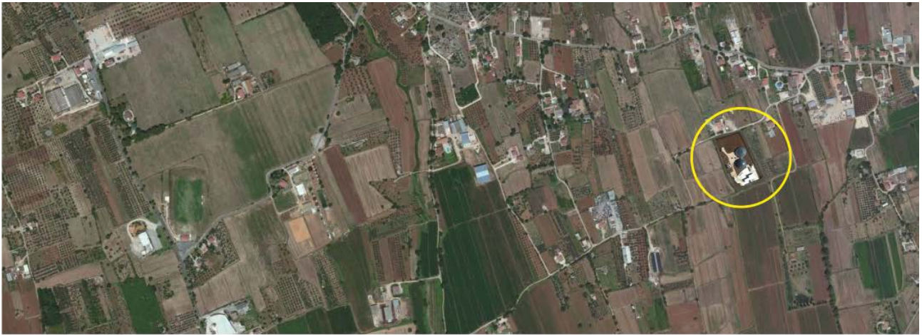
Centrale BIOGAS, località FARNETO, Via Vorca Lannetta - MAENZA
